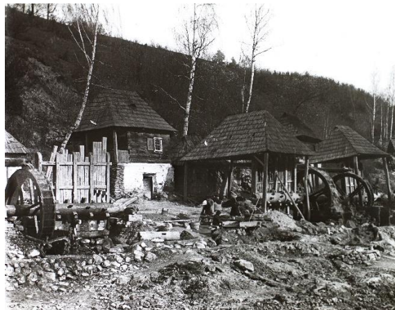
Az aranytartalmú érc aprítására szolgáló aranyúzó Verespatakon Dörre Tivadar illusztrációján (Forrás: Lukács Béla: Az erdélyi aranybányászat ) és a XX. század elején (Forrás: Fortepan / Magyar Földrajzi Múzeum / Diagyűjtemény)
