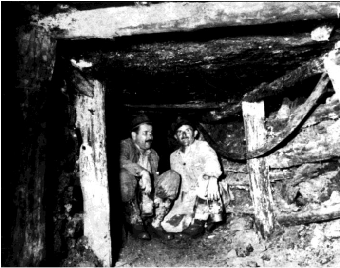
Fával biztosított bánya Edelényben, az 1950-es években (forrás: Bányászattörténeti közlemények)
