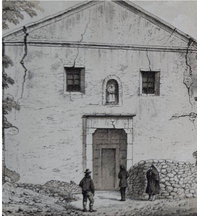
Pertosa templomhomlokzatának repedései (forrás: Mallet: Az 1857-es nagy nápolyi földrengés)
